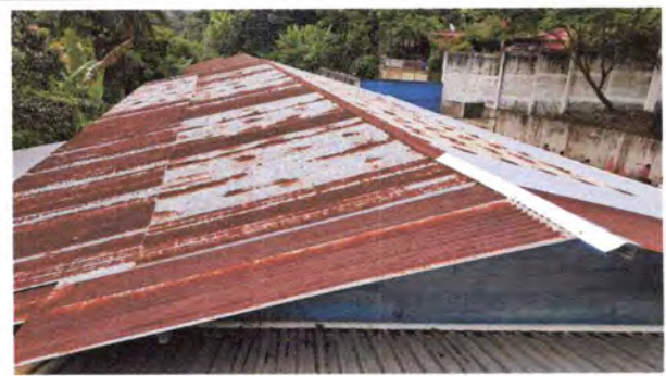
Foto 2: Módulo 2: Cubierta de lámina de zinc.
