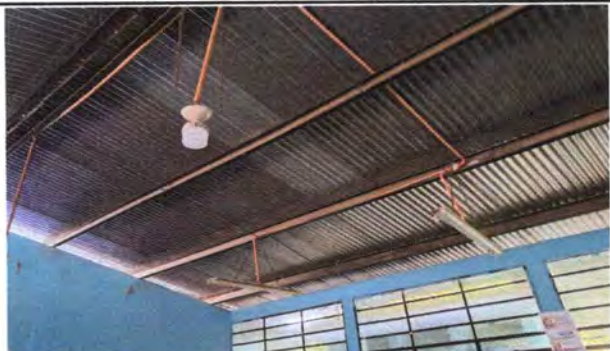
Foto 1: Módulo 2: vista interior de la Estructura de Techo al cual se le dará mantenimiento: lijado y aplicación de pintura anticorrosiva.
