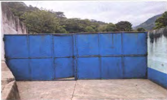
Foto 5: Vista exterior del portón de ingreso al establecimiento, al cual se le instalará estructura de techo y cubierta de lámina, debido que se encuentra a la intemperie para una mayor durabilidad y evitar su corrosión.
